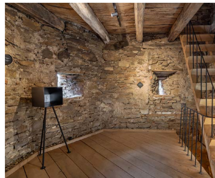
Restaurarea TURNULUI ȘI BASTIONULUI MĂCELARILOR, Sighișoara
