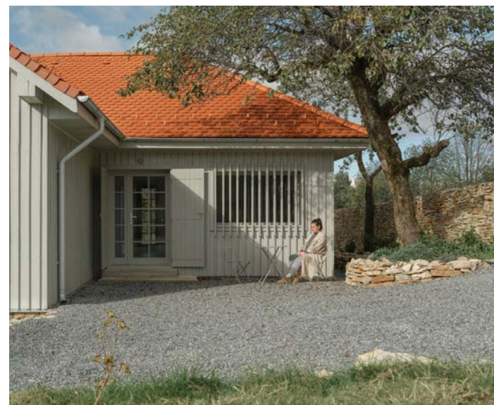
Recuperarea unei locuințe și a unei șuri la țară, Cluj
