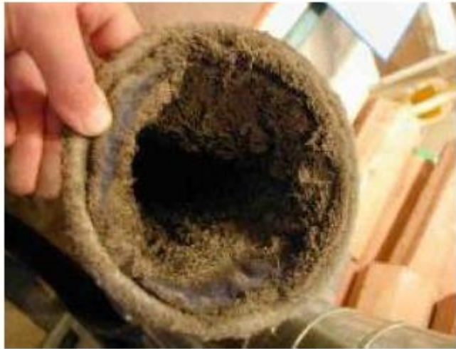
Figure 40 : remplacement d'un filtre à air
