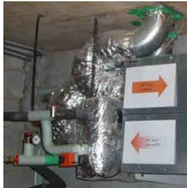
Figure 54 : exemple d'isolation de gaines de ventilation dans une maison passive à Neufchâteau (source : Passeurs d'Énergie asbl)
