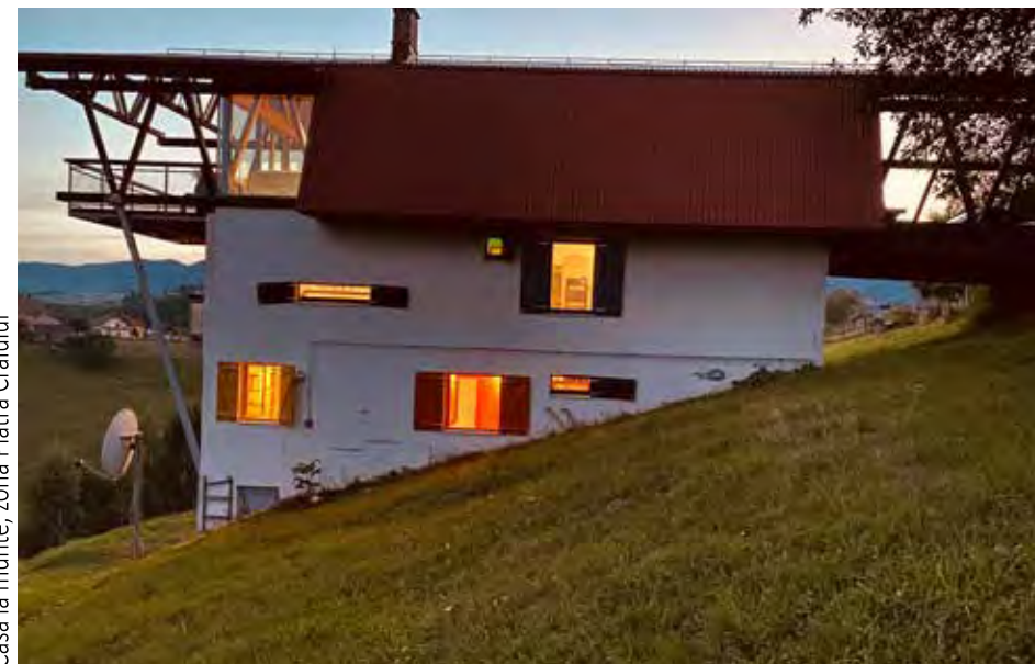
Casă la munte, zona Piatra Craiului
