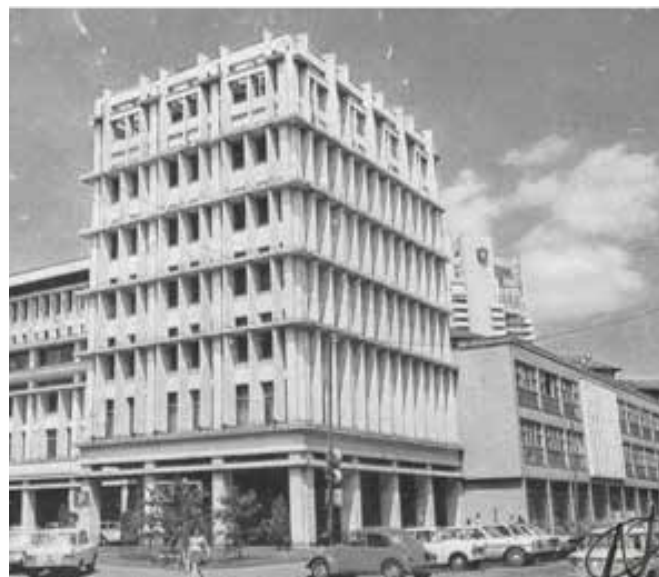
Dezvoltarea UAUIM, aripa Academiei
