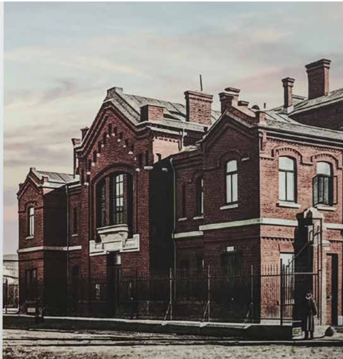
Bursa de Mărfuri, edificiu de control și locuințe - Antrepozitele Generale, București, 1894-1896, 1898
