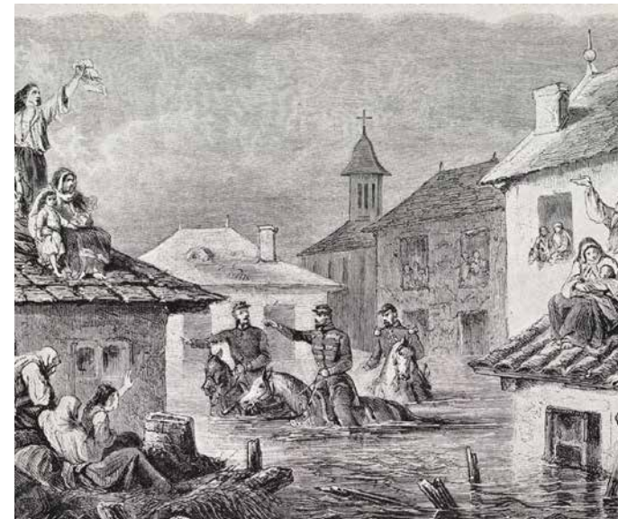
Inundațiile din 1865 au determinat modernizarea infrastructurii Bucureștiului
